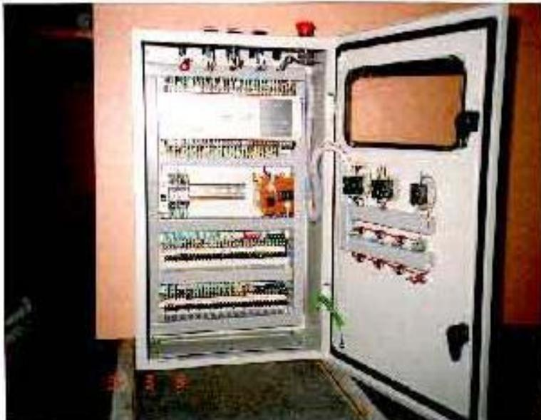
Fig. 6 - Tipico esempio di pannello realizzato mediante PLC
